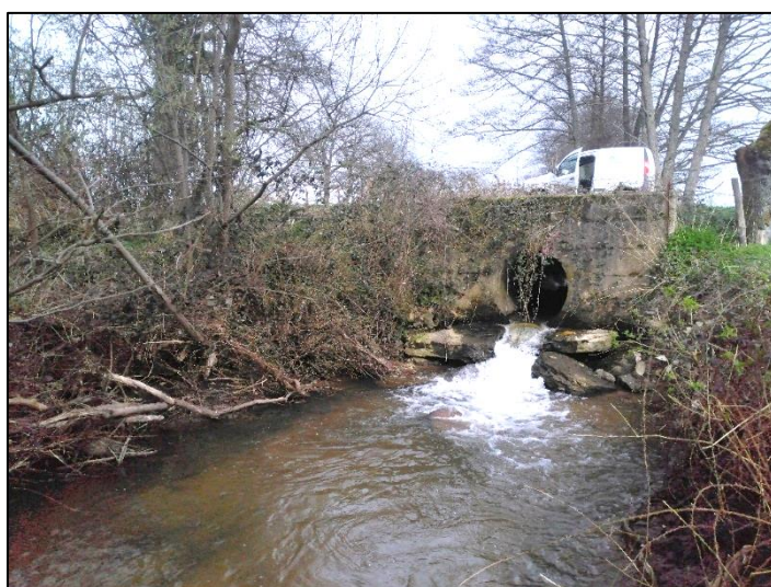
Figure 27. Buse sous voirie sur la Lacanche - JR
