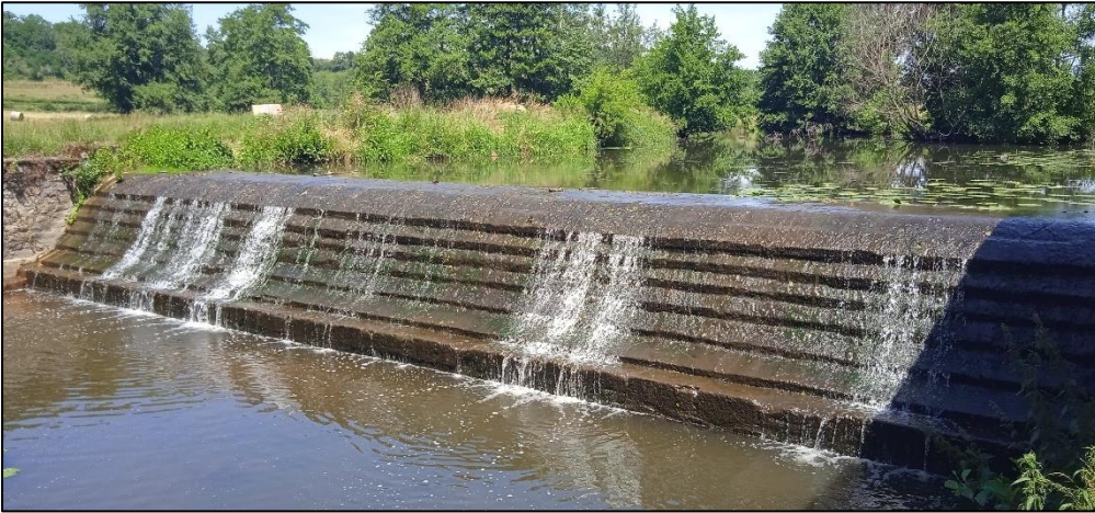
Figure 15. Seuil du moulin Francy – juin 2022 – JR.
