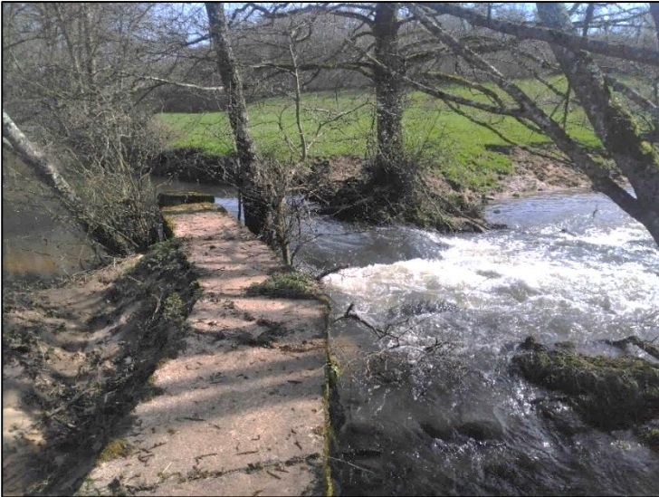
Figure 22. Seuil à l'amont du moulin Auxerain - Lacanche - JR
