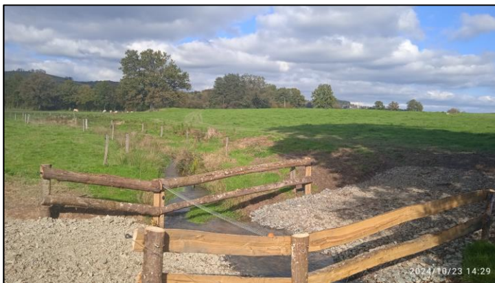
Figure 12. Photo d'un passage à gué sur le Laizy - SC
